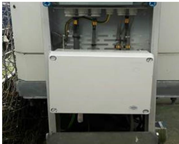
Figuur 5-23 Montage KOK m.b.v. T-bouten en afstandsbusjes..
