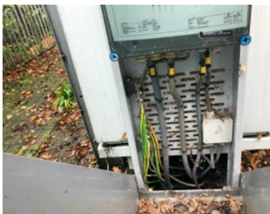
Figuur 5-22 KOK onder de K2 en achter de beschermkap gemonteerd.
