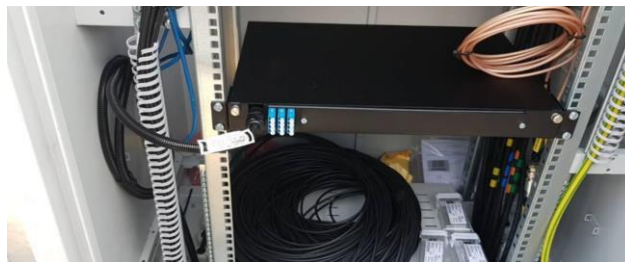
Figuur 5-19 Voorbeeld: bevestiging gas-/waterblokkade en overlengte. (let op: 1 lus!)
